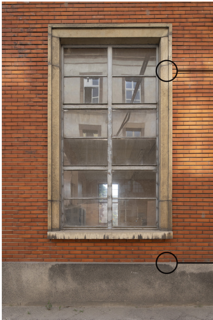
encadrement fenêtre en béton
