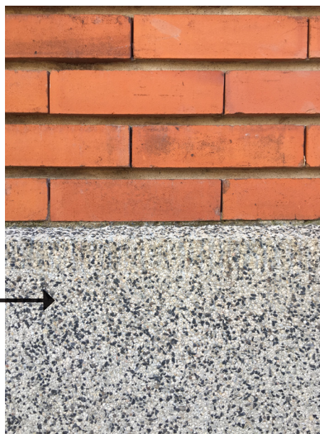
brique + sous-bassement en béton
